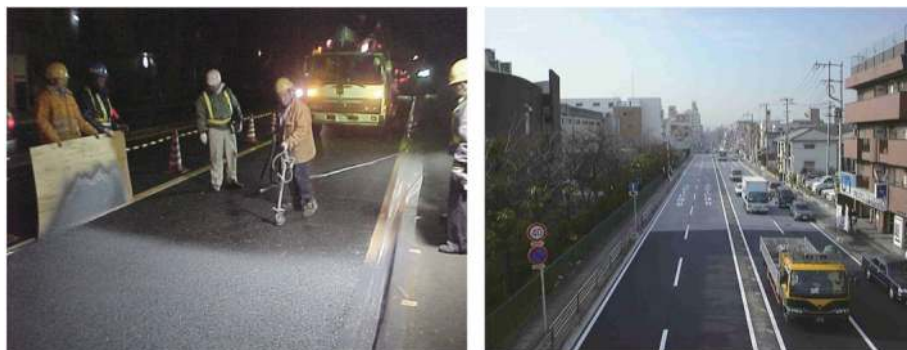
图 17 日本东京市的氧化钛复合混凝土路面
